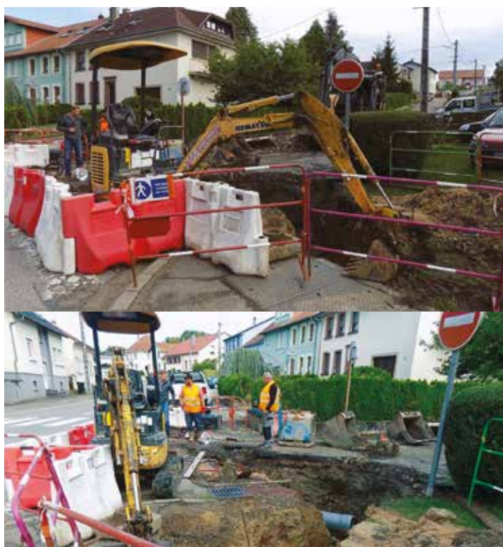
Début des travaux rue de la paix
