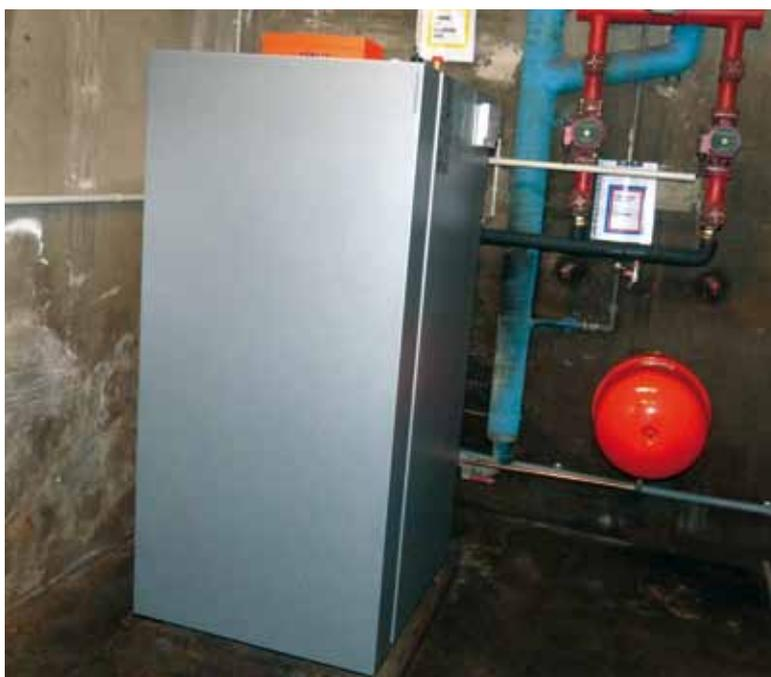
La chaudière de l'école maternelle a été remplacée par une chaudière au gaz par l'entreprise BF Maintenance de Diebling.
